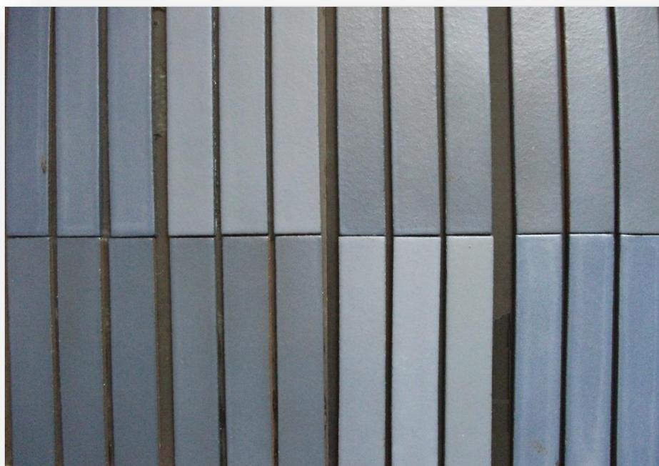
No.389では、‘特注ボーダーメタリックブルー’ご紹介致します。製法は湿式ハンドメイドプレス製法です。土練器で圧縮成形された帯状の生地を焼成後 195×35mm 程度になるようピアノ線でカット、プレスで圧縮成形して、乾燥・メタリック調の釉薬で施釉・焼成して制作致しました。ハンドメイドの質感が若干抑えられメタリック調の釉薬と相まって独特の空間を作り出します。特注色対応可能です。
